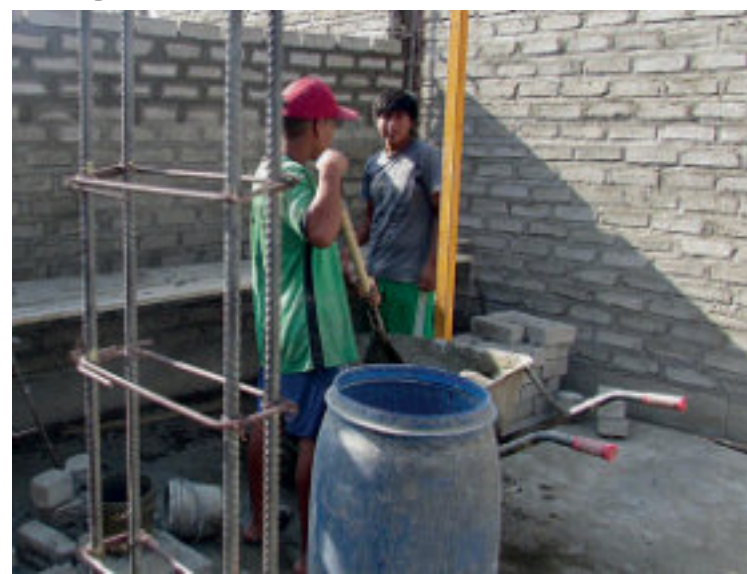
Jugendliche Helfer auf der Baustelle.
