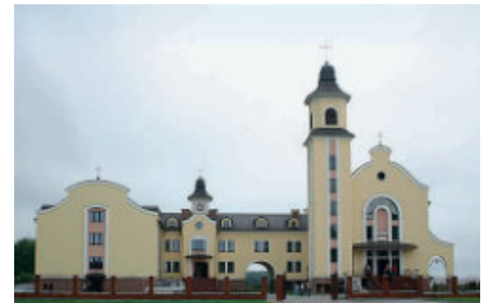
Foto: Ch. Heinemann
