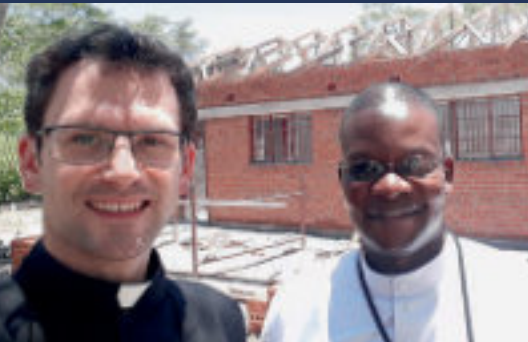
P. Karel und P. Charles besuchen die Baustelle der Missionsstation in Maraire. Mittlerweile fehlt nur noch die Strom- und Wasserinstallation.
